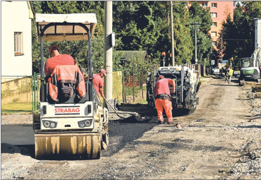
Začaly práce na výměně povrchu rekonstrukci plynovodu na ulicích Sportovní a Záhumenní. FOTO: DAVID MACHÁČEK
