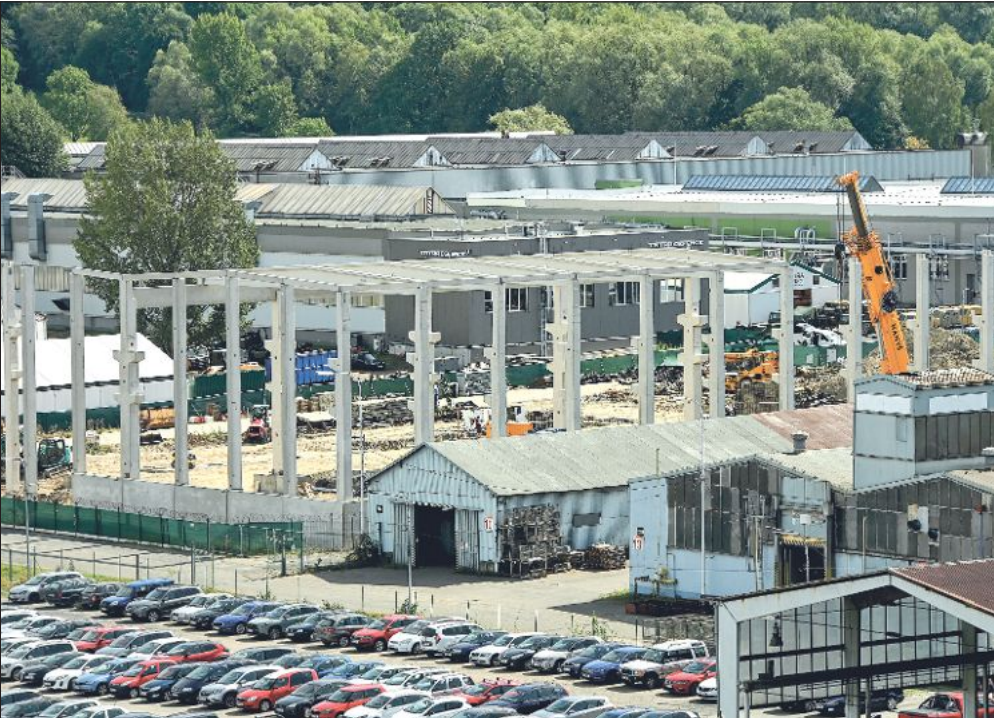
Stavba nové výrobní haly Tatra Defence Vehicle by měla být dokončena ještě před koncem letošního roku. Následovat mají další investice.
