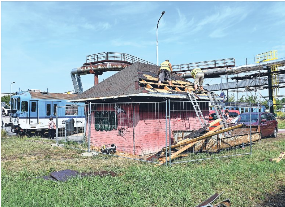
Souběžně s opravou horkovodu začaly práce na přestavbě přístřešku pro cestující na vlakové zastávce. Dokončena by měla být na konci září.
