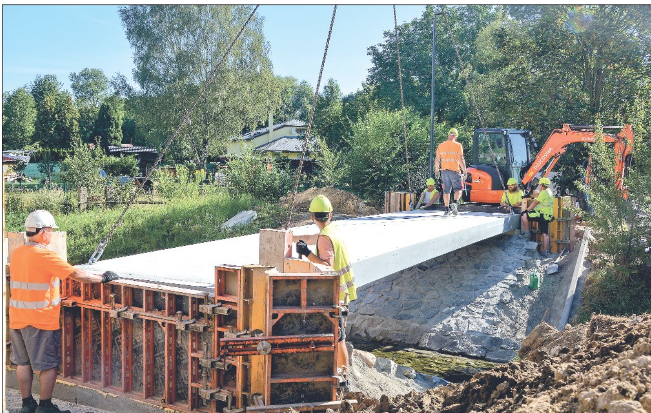
V minulém týdnu překlenula Kopřivničku mostovka lávky pro pěší spojující ulice Francouzskou a Dolní. Využitím prefabrikovaného dílu z vysokopevnostního betonu byla rekonstrukce zkrácena o několik týdnů. FOTO: DANA HOĐÁKOVÁ
