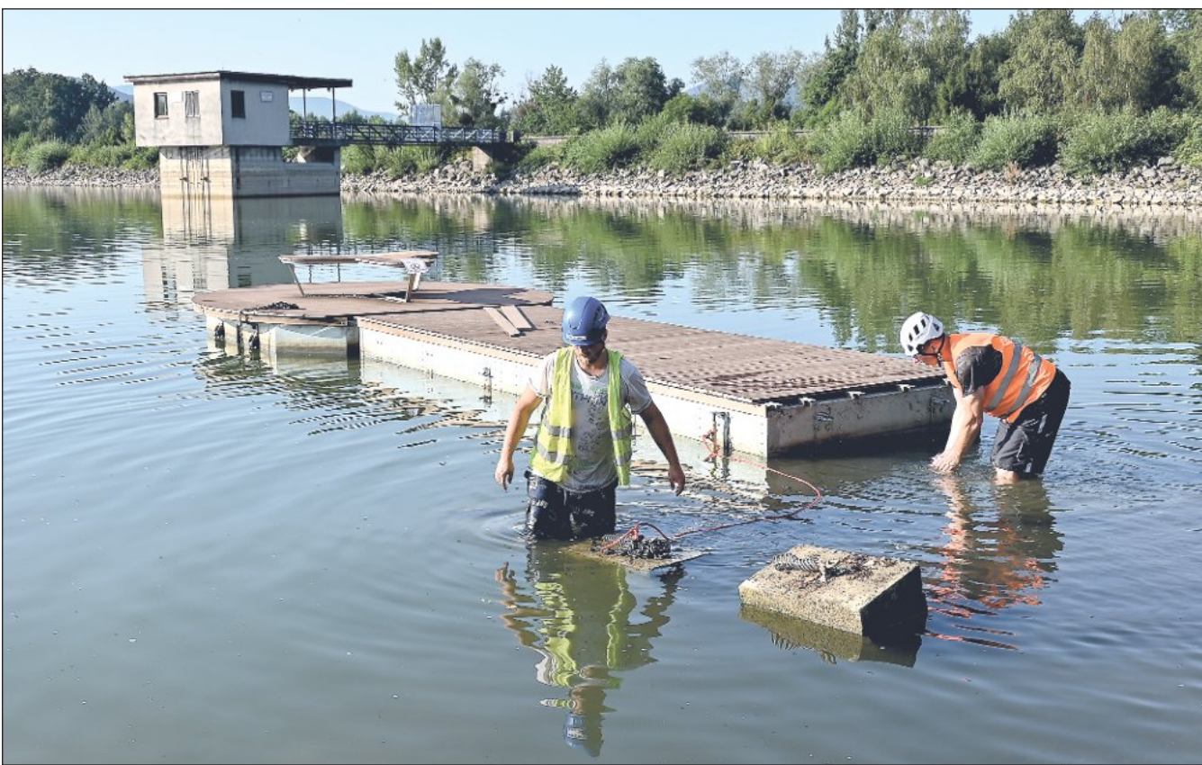
V úterý 4. srpna došlo k posunu mola na přehradě ve Větrkovicích. Kvůli snížené hladině vody v nádrži molo už neplnilo svou funkci, a tak Správa sportovišť Kopřivnice objednala specializovanou firmu, která ukotvila pontony dále od břehu. FOTO: D. MACHÁČEK
