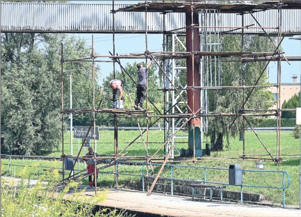
Revitalizace nadzemního teplovodu uzavřela chodník kolem vlakové zastávky nejen pro pěší, ale i průjezd cyklistů. Současně bude probíhat i rekonstrukce vlakové zastávky. FOTO: D. MACHÁČEK
