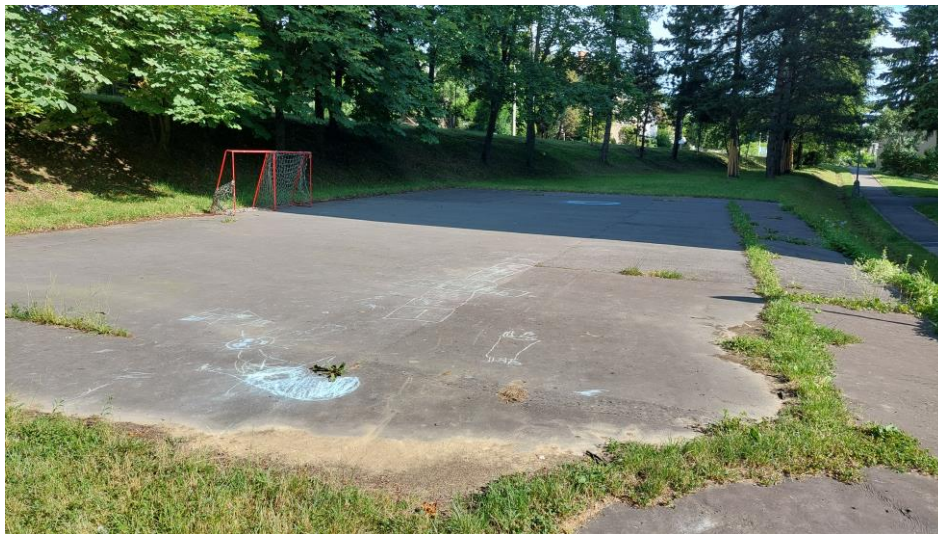
Sportoviště 10 (asfaltace ul. Francouzská)
