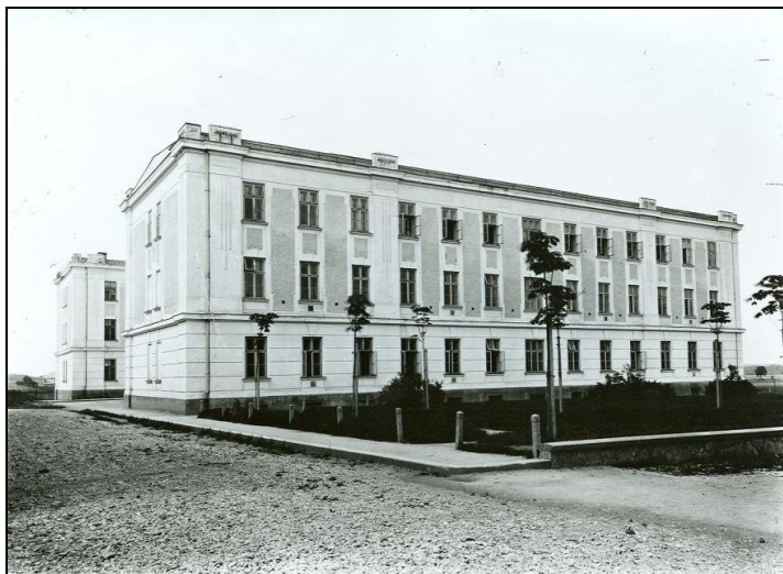
Objekt „Kasárna“ na ul. Česká č.p. 318
