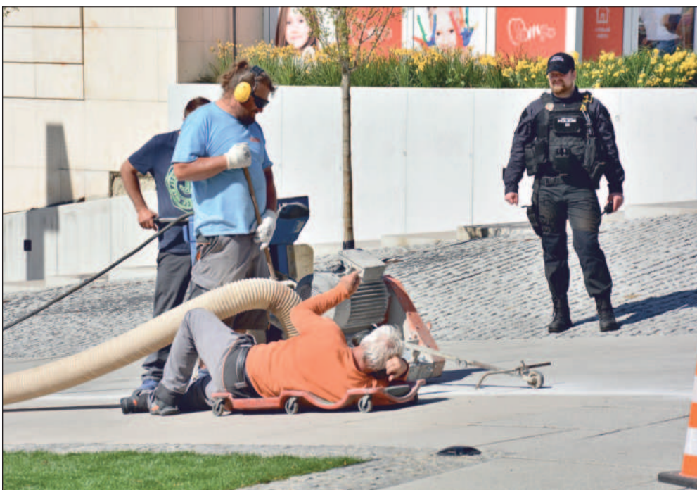
V minulém týdnu proběhla úprava vodících drážek, které mají usnadnit pohyb slabozrakých a nevidomých lidí v rekonstruovaném centru města. FOTO: DAVID MACHÁČEK
