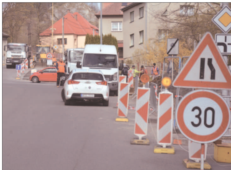
Práce na úpravách křižovatky pod Palárnou byly zahájeny 1. dubna. Společný projekt Kopřivnice a Štramberka má zvýšit bezpečnost chodců.
