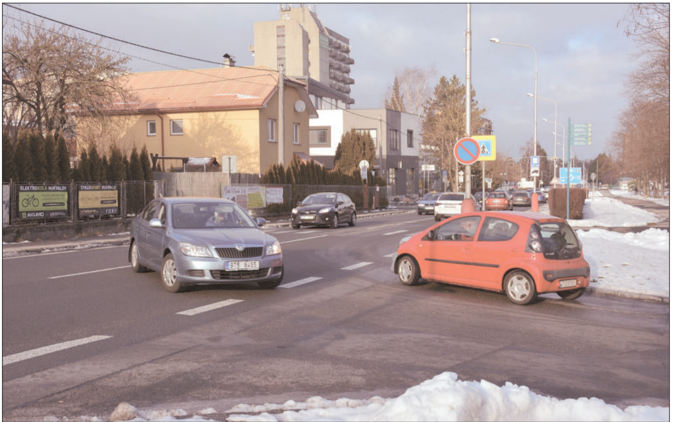
Křižovatka ulic Záhumenní a Kpt. Jaroše se ještě letos promění v okružní. Zhotovitel stavby už byl vybrán a začala také jednání o úpravách dopravy ve městě s cílem minimalizovat negativní dopad uzavření místa během stavby. FOTO: DAVID MACHÁČEK
