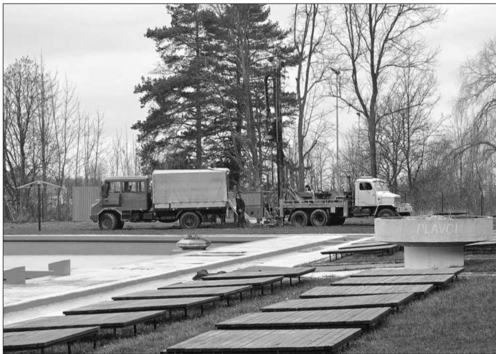
V rámci pokračujícího projektování rekonstrukce letního koupaliště byly v minulém týdnu provedeny sondy, které mají ověřit stabilitu podloží.
