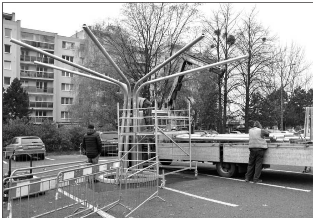
Montáž konstrukcí ocelových stromů, které mají v budoucnu zastínit část parkoviště před radnicí, proběhla minulý týden. Výsadba popínavých rostlin je v plánu v nejbližší době. FOTO: D. MACHÁČEK
