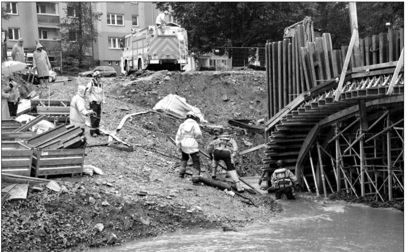
Mezi víkendové zásahy kopřivnických dobrovolných hasičů patřilo i uvolnění průtoku pod konstrukcí, která držela čerstvě vybetonovaný oblouk nového mostu na ulici Erbenově. FOTO: DAVID MACHÁČEK
