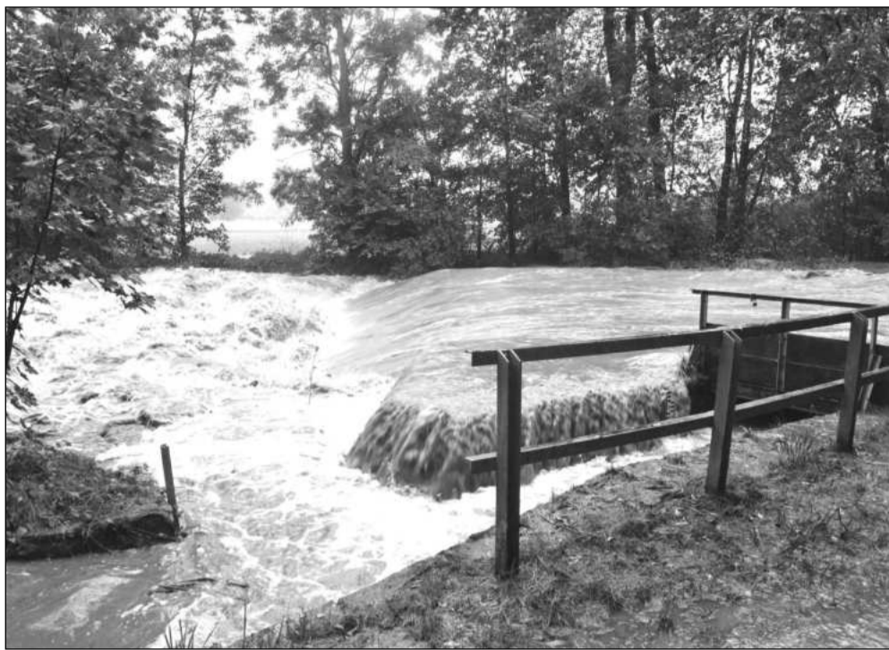
Jedním z nejkritičtějších míst víkendové povodně na území Kopřivnice byl splav na horním konci Vlčovic. V době pořízení snímků se korytem valilo zhruba 141 m 3 vody za vteřinu.
