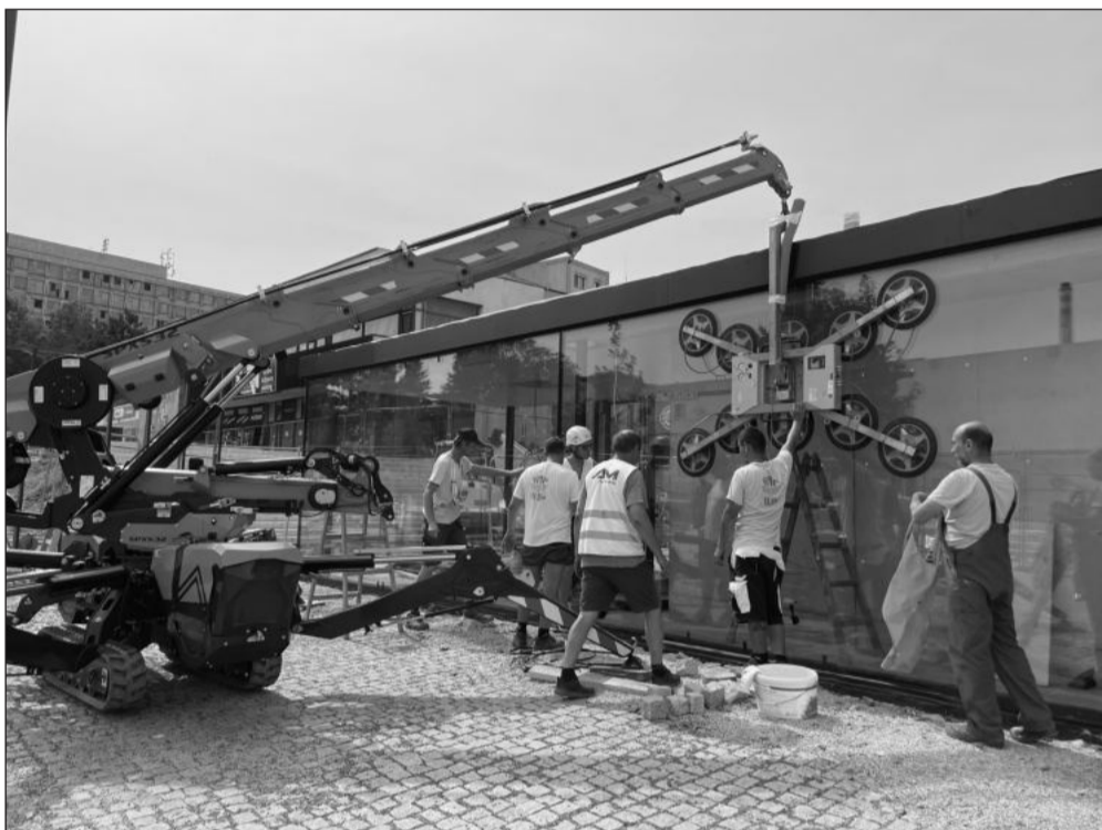
Práce na revitalizaci centra pokračují. V závěru minulého týdne došlo k instalaci zhruba tunu těžkých skleněných stěn do objektu budoucího výstavního pavilonu. FOTO: LENKA KRHOVJÁKOVÁ
