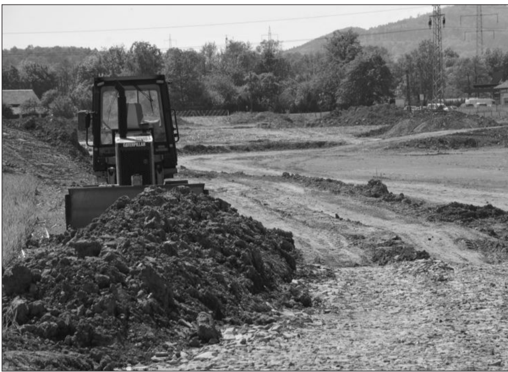
V lokalitě na Holotě v Lubině probíhá výstavba hrázky a odvodňovacího příkopu, které mají zabránit zaplavení zahrady a sklepů nedalekých domů. FOTO: DAVID MACHÁČEK
