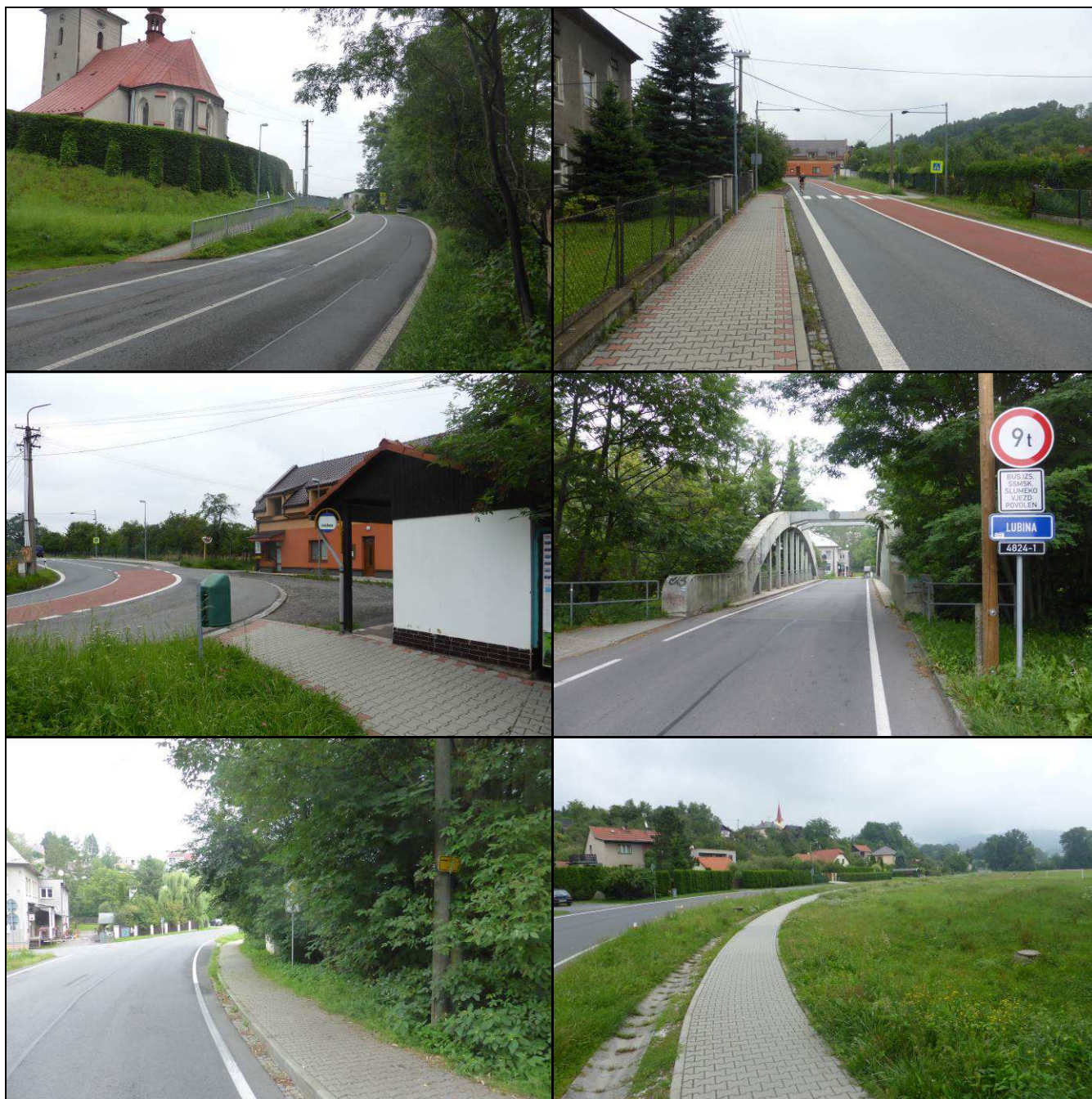
FOTOGRAFIE Č. 37 – ÚZKÝ PROFIL VE VLČOVICÍCH PODÉL SILNICE I/58
