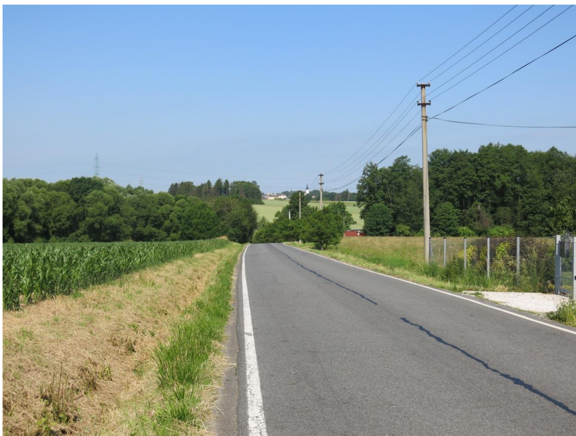
12) Silnice III/4863 od Hájova k Příboru (ul. Hukvaldská).
