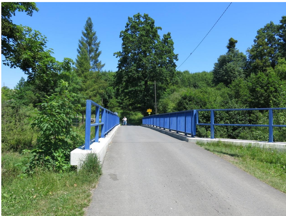
1) Most přes vodní tok Lubinu – propojení mezi k.ú. Větrovice u Lubiny a Drnholcem nad Lubinou.
