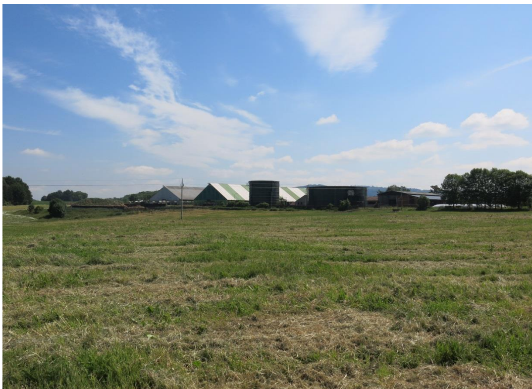
1) Zemědělský areál v severní části zastavěného území Větrčovic u Lubiny – pohled na jeho západní část.
