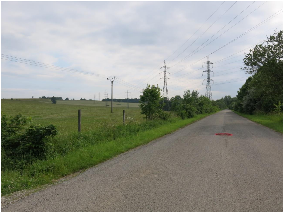
6) Vedení VN a VVN v jihovýchodní části k.ú. Klokočova u Příbora a pěkně označený výtluk na komunikaci souběžné se silnicí I/48.
