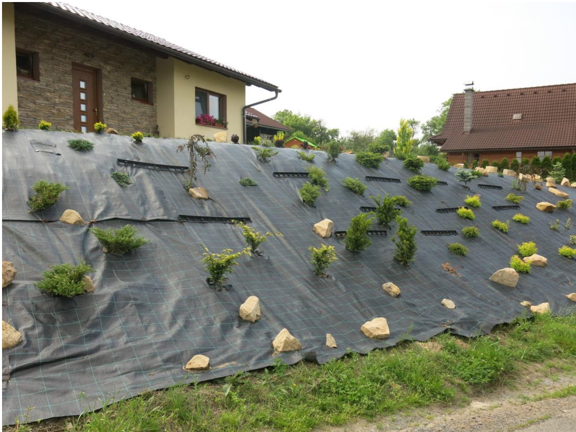
5) Terénní úpravy u rodinného domu v centrální části zástavby, ul. Lesní.
