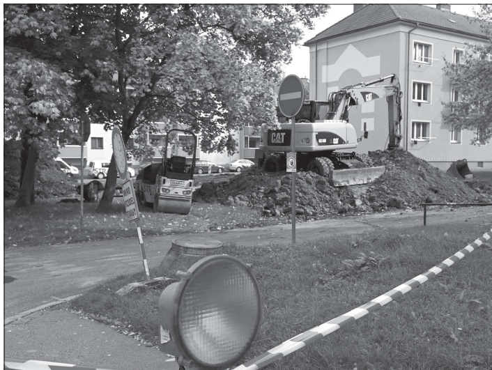
Výstavba parkoviště na rohu ulic Zdeňka Buriana a Javorové začala minulý týden zemními pracemi. Nová odstavná plocha bude k dispozici v polovině prosince. FOTO: DAVID MACHÁČEK
