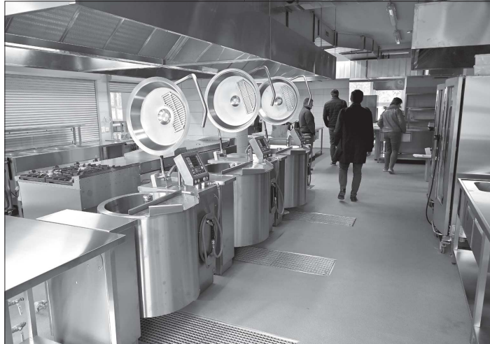
V minulém týdnu proběhly poslední dokončovací práce na kompletní rekonstrukci školní kuchyně na ZŠ Alšově. FOTO: DAVID MACHÁČEK
