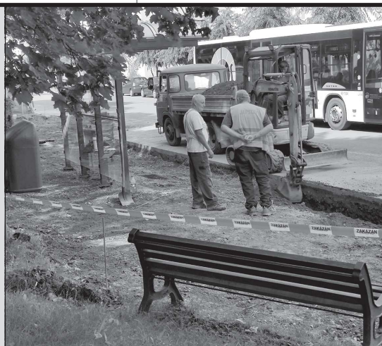
Úroveň autobusové zastávky na ulici Obránců míru se má kvůli snazšímu nástupu snížit o osm centimetrů. FOTO: DAVID MACHÁČEK
