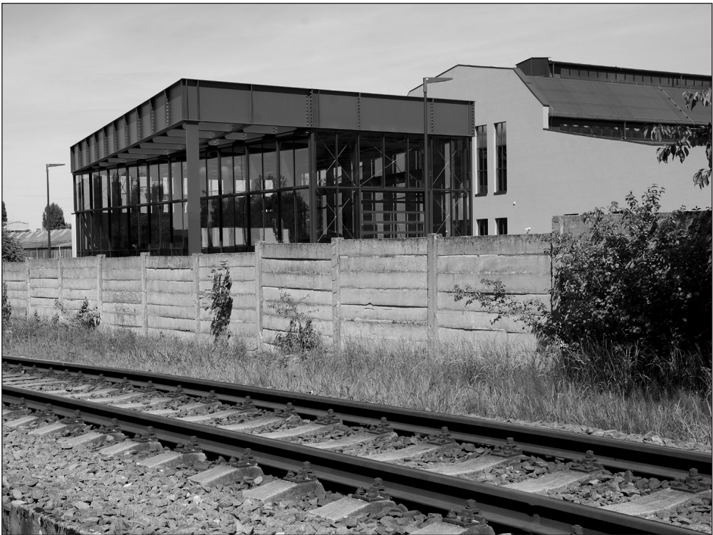
Nevzhledná betonová zeď oddělující železniční trať a prostor s Muzeem nákladních automobilů Tatra a výstavním depozitářem Slovenské strelý bude zbourána. FOTO: DAVID MACHÁČEK
