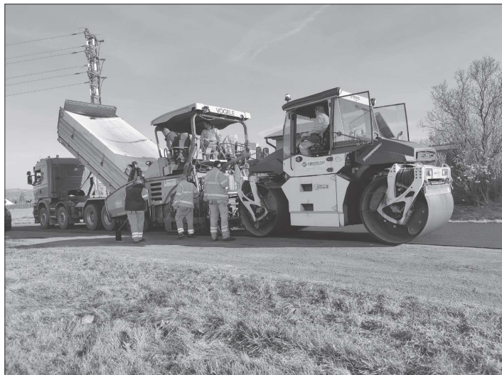
Rekonstrukce povrchu komunikace na ulici K Očínmu navázala na opravy provedené v nedávné době. Tentokrát firma Swietelsky stavební, s. r. o., opravovala úsek dlouhý cca 460 m. Kompletní práce by měly být na této komunikaci dokončeny v těchto dnech. FOTO: DAVID MACHÁČEK
