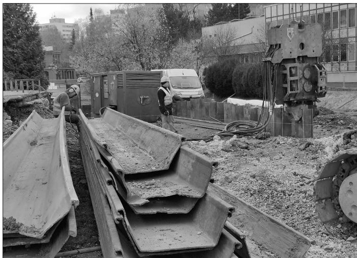
Speciální beranidlo v minulém týdnu zpevňovalo hlubokou stavební jámu v centru města, ve které bude umístěna objemná nádrž na dešťovou vodu. FOTO: DAVID MACHÁČEK
