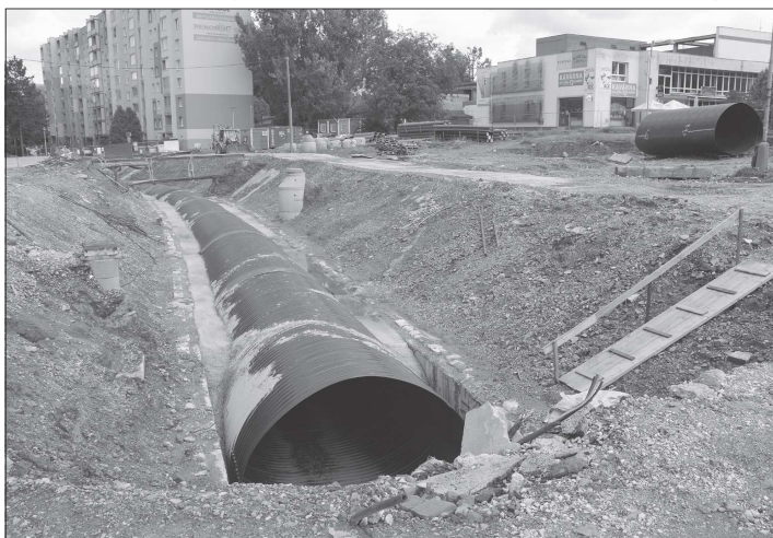
Staveniště v centru města je v posledních dnech a týdnech téměř pusté. Důvodem jsou podle zástupců radnice administrativní nedostatky na straně zhotovitele. FOTO: D. MACHÁČEK
