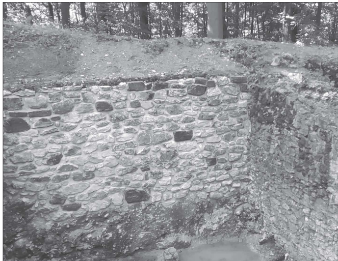
Oprava staticky narušených zbytků zdi hradního paláce Šostýna skončila v dvouměsíčním předstihu. FOTO: ESTER LAKATOŠOVÁ
