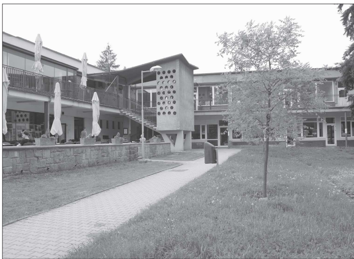
Rekonstrukce vnitřních rozvodů v multifunkčním objektu na ulici Školní se chýlí k závěru. Radnice už spráda plány na opravu schodiště i úpravy okolních ploch. FOTO: DAVID MACHÁČEK
