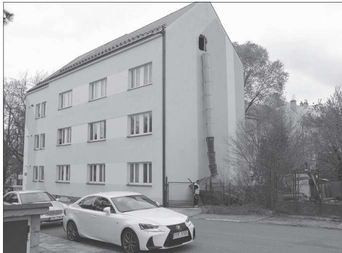
Minulý týden začala odkládaná rekonstrukce domu s byty zvláštního určení na Masarykově náměstí. Práce zatím probíhají ve společných prostorách. FOTO: DAVID MACHÁČEK
