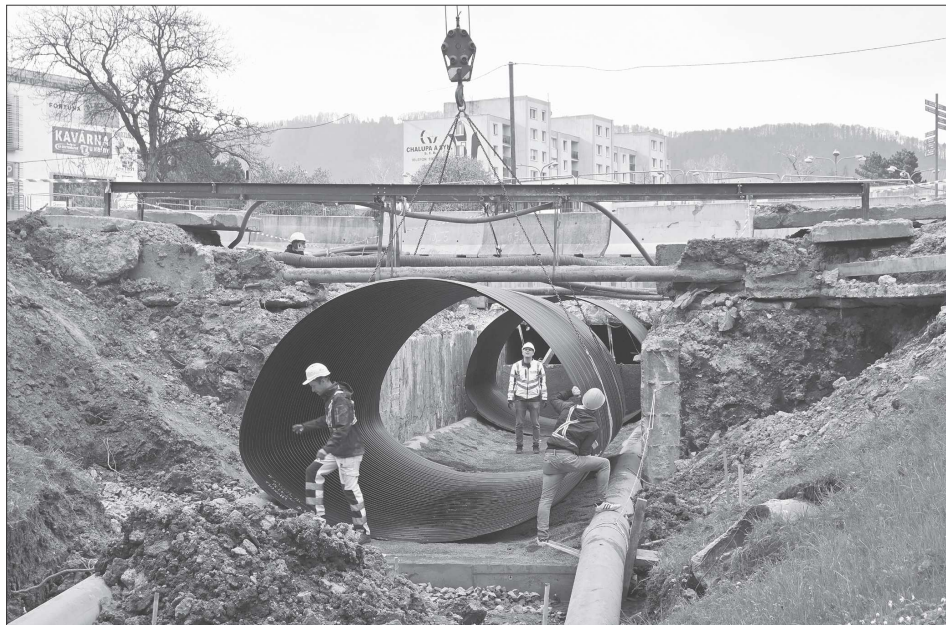
V rámci výměny zatrubnění Kopřivničky byly na místo usazeny první části tubosideru, kterým bude nejspíše letos na podzim potok protékat v úseku od hotelu Tatra po ZŠ Milady Horákové.
