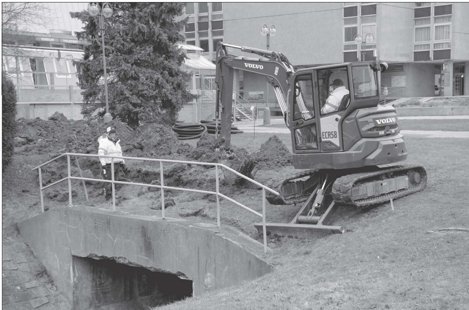
První výkopové práce v centru města s jeho revitalizací souvisí zatím jen nepřímo. Jde o přeložku vedení elektrické energie. Hned po jejím dokončení začne etapa obnovy zatrubnění Kopřivničky. FOTO: DAVID MACHÁČEK
