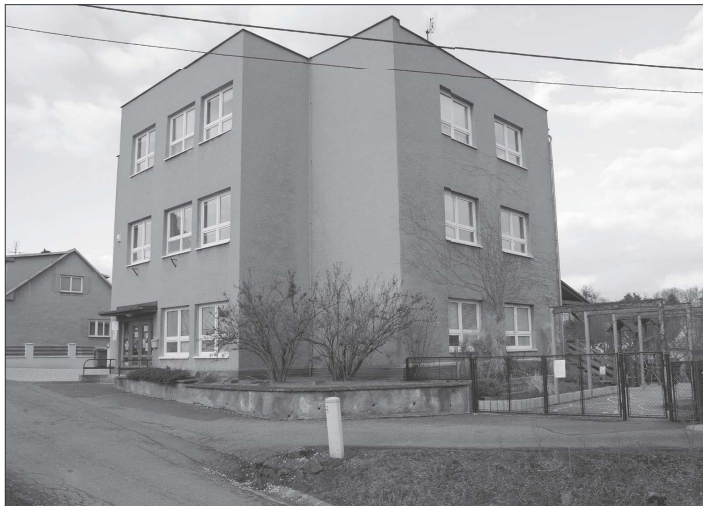
Budova Mateřské školy v Lubině se letos v létě dočká zateplení a výměny elektroinstalace.
