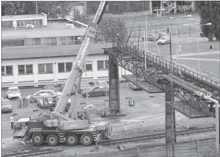
Výluku na železniční trati mezi Příborem a Štramberkem využila společnost Tatra Trucks k demontáži technologického mostu za budovou dnešní radnice. FOTO: DAVID MACHÁČEK
