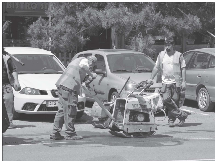
Kromě průběžných oprav výtlučků se chystají i rekonstrukce většího rozsahu. Nového povrchu se dočká například část ulice Školní.
