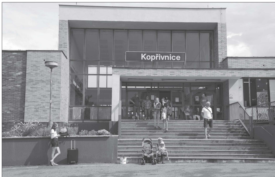
Budova kopřivnického vlakového nádraží by se slibované rekonstrukce mohla dočkat už v roce 2022. Zástupci Správy železnic na radnici prezentovali první plány rekonstrukce. FOTO: DAVID MACHÁČEK
