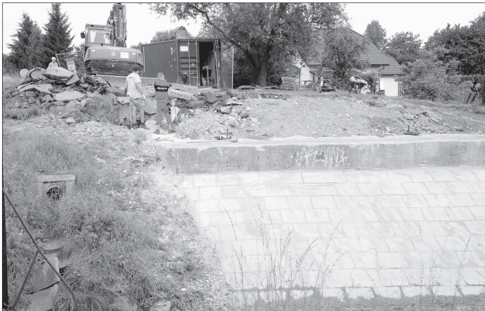
Přívodní most na ulici Severní v minulých týdnech prováděcí firma zdemolovala. Výstavba nového přemostění Kopřivničky by měla být dokončena do poloviny listopadu. FOTO: DAVID MACHÁČEK
