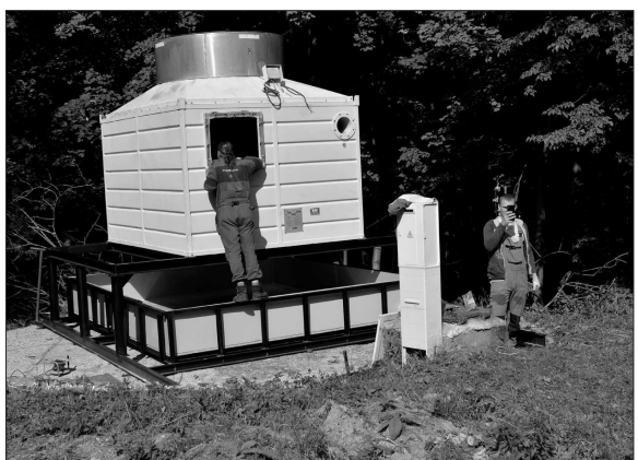
V minulém týdnu byla u svahu zdejší sjezdovky instalována chladicí věž, která má během sezony zefektivnit umělé zasněžování. FOTO: D. MACHÁČEK
