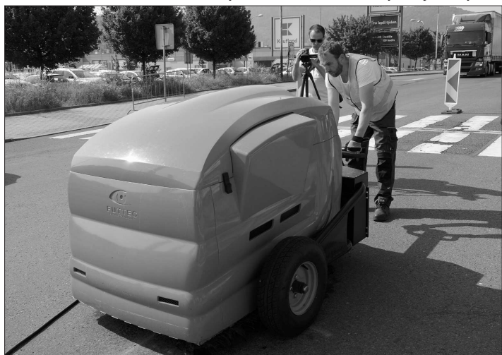
Na ulici Štefánikově bylo prezentováno, jak funguje nové mikrovlnné zařízení na úpravu výtluků. V budoucnu by se na silnicích ve městě mělo objevovat častěji. FOTO: DAVID MACHÁČEK
