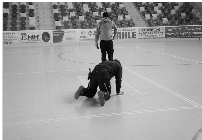
Během dvou dnů se kopřivnický zimní stadion proměnil v nové, multifunkční sportovní zařízení. V jednom dni byl položen nový povrch a druhý den jej pracovníci specializované firmy nalajnovali podle požadavků správy sportovišť. FOTO: DAVID MACHÁČEK
