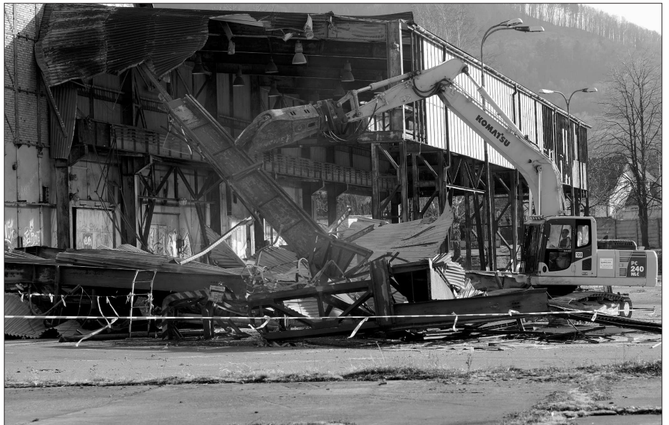
Před týdnem začaly demoliční práce u budovy bývalé tatrovácké haly, která se má už v letošním roce začít měnit v nové muzeum automobilů. Demolice ale zatím není přímou součástí rekonstrukce. FOTO: DAVID MACHÁČEK
