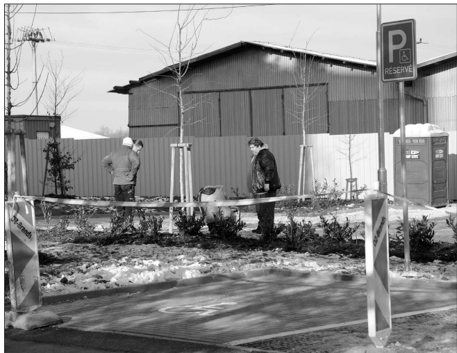
V pondělí probíhaly na novém parkovišti poslední úpravy. Od včerejšího dne už jej mohou obyvatelé sídliště Sever využívat k odstavení svých vozidel. FOTO: D. MACHÁČEK
