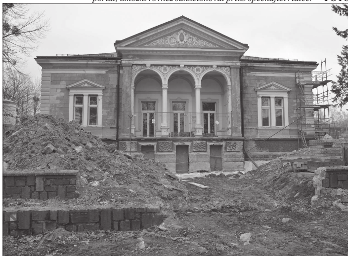
Probíhající rekonstrukce Ringhofferovy vily a nutnost navýšení rozpočtu projektu budou jediným bodem mimořádného jednání zastupitelstva. FOTO: DAVID MACHÁČEK
