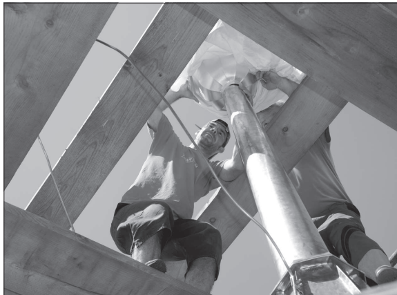
Klempíři instalují na vrchol věže vlčovického kostela pozlacenou makovici, v jejímž nitru je uložena časová schránka. FOTO: DAVID MACHÁČEK
