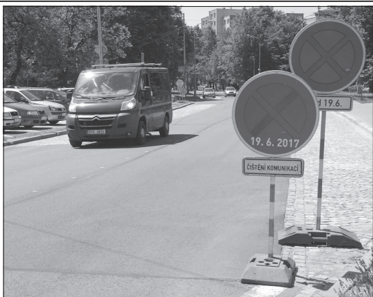
Do konce června musí řidiči počítat na Štramberské s omezením, které způsobí instalace dopravního značení. FOTO: DAVID MACHÁČEK
