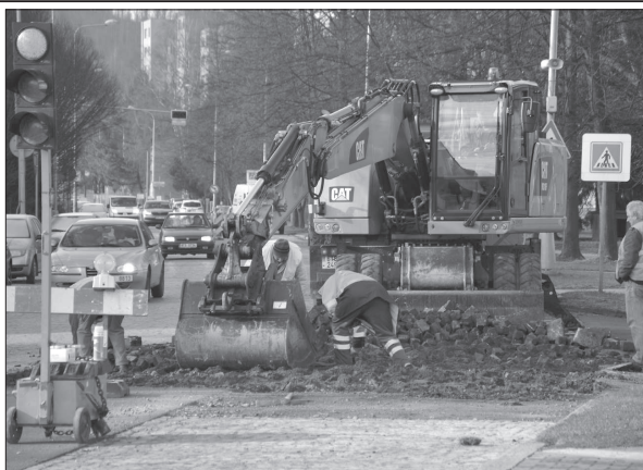
V pondělí ráno bagr odstraňoval ze silnice na ulici Štramberské staré dlažební kostky, aby se naplno mohly rozjet stavební práce. FOTO: DANA HOĐÁKOVÁ
