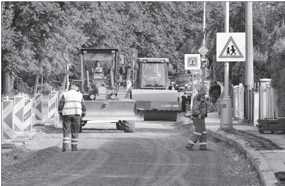
Práce na rekonstrukci ulice Štramberské zatím běží podle schváleného harmonogramu. V tomto týdnu by měly být vyasfaltovány opravené úseky průjezdné komunikace a opravy by se měly přesunout na druhou stranu. FOTO: DAVID MACHÁČEK
