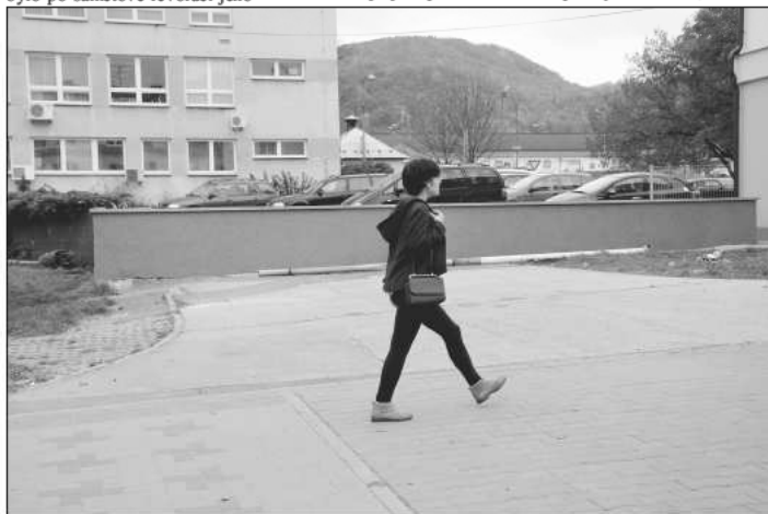
Zidka, která přehradila frekventovaný chodník u místní polikliniky, bude důvodem místního šetření v rámci aktuálně probíhajícího řízení o dodatečném povolení stavby. FOTO: DAVID MACHÁČEK
