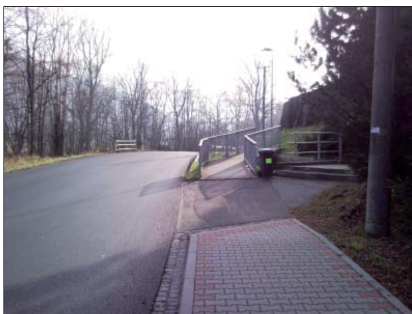
Foto 54: Pod kostelem u požární zbrojnice (km 3,85)
