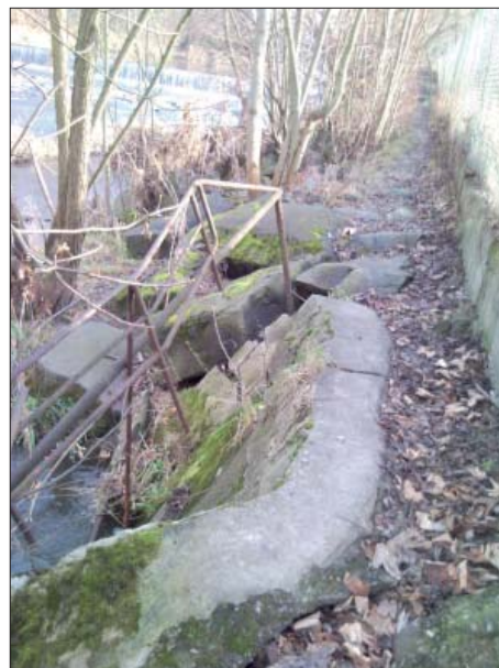
Foto 04: Výpusť úpravny vody
