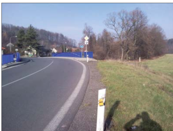
Foto 55: Konec trasy (silniční most přes Lubinu) - pohled od Tiché (km 4,44)
