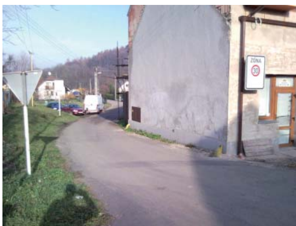
Foto 52: Vyústění místní komunikace na silnici č. I/58 (km 3,7)
