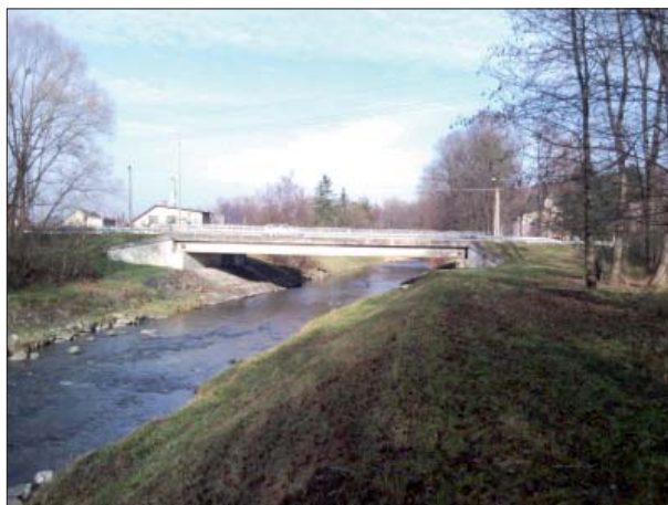
Foto 08: Pohled k silničnímu mostu (pravý břeh Lubiny)
