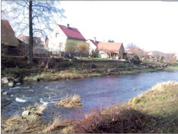
Foto 26: Předpokládané místo křížení toku Lubina (km 4,15)
