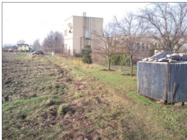
Foto 18: Začátek stavebního úseku (km 1,25-1,3)
