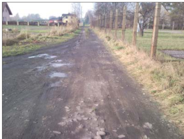
Foto 17: Konec místní komunikace u úpravny vody (km 1,2)
