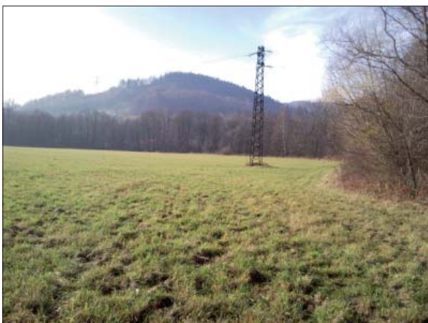
Foto 30: Trasa vedena okrajem louky (km 4,7)
