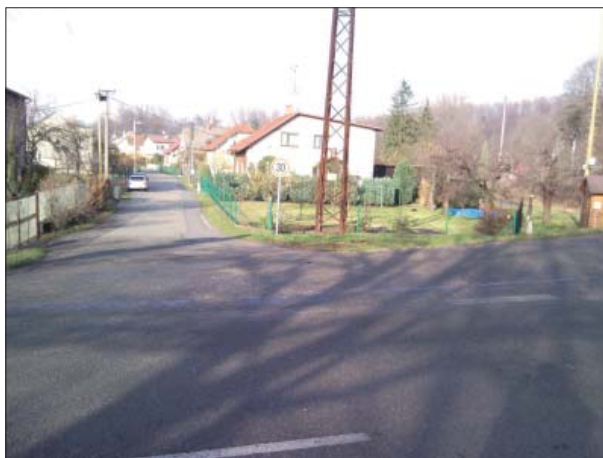
Foto 45: Napojení místní komunikace na silnici č. II/486 (km 2,73)
