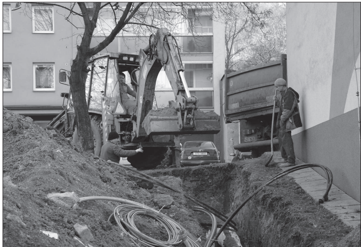
Stavební čety po položení potrubí a kabelů zahrnují výkopy, aby v případě příchodu zimy mohla být prováděna údržba chodníků a parkovišť. Práce přeruší jen na svátky. FOTO: DAVID MACHÁČEK
