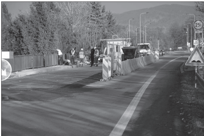
Práce na opravě první poloviny mostu by měla firma dokončit tento týden. Následně by se pak most měl zcela otevřít pro dopravu a rekonstrukce bude pokračovat na jaře. FOTO: DAVID MACHÁČEK
