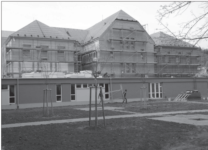
Rekonstrukce ZŠ dr. Milady Horákové se chýlí ke konci. Stavební práce by měly být dokončeny v polovině měsíce. FOTO: DAVID MACHÁČEK
