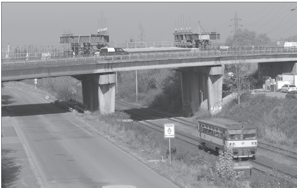
Práce na opravách silničního mostu pokračují. Pod zvednutou polovinou mostovky se pracuje na čištění nosníků a výměně ložisek. Práce zatím pokračují podle harmonogramu, zbrzdit je mohou až nevhodné klimatické podmínky. FOTO: DAVID MACHÁČEK
