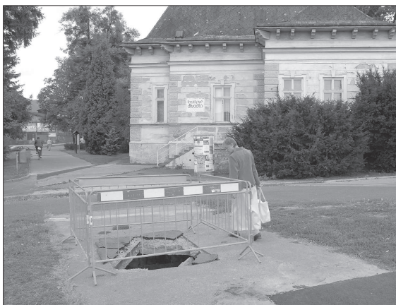
Díra v chodníku odkryla pohled na historickou studnu, přes kterou lidé chodili, aniž by o její existenci měli tušení.
