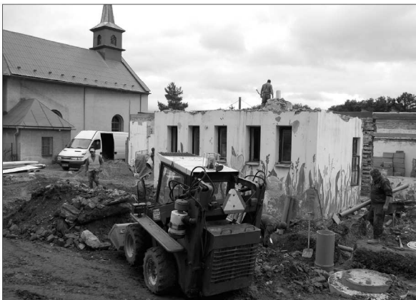
Pouze obvodové zdi zbyly z dosavadní budovy ZŠ v Mniší. Nově zrekonstruovaná budova má být dokončena v dubnu 2012. FOTO: DANA HOĐÁKOVÁ
