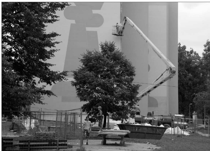
Do konce roku by měly skončit práce na regeneraci panelových domů na sídlišti Jih.
