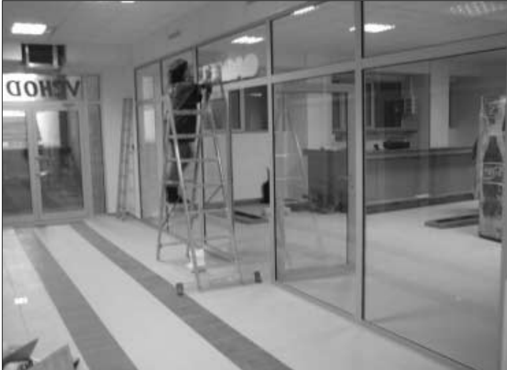
Minulý týden ještě v suterénu hotelu probíhaly přípravné práce, tento týden už nová obchodní pasáž vítala první zákazníky.
