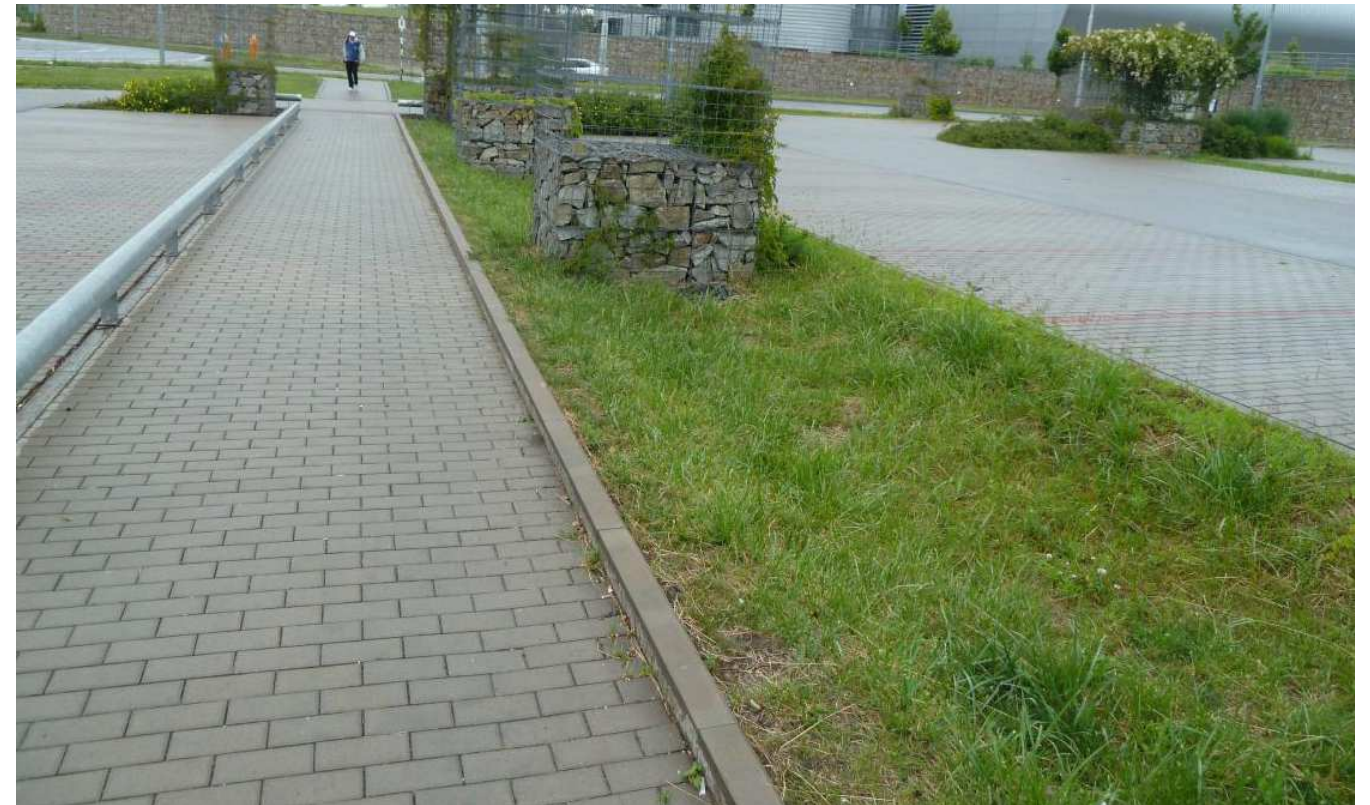
Obr.: Velký vsakovací průleh (zdroj: publikace „Vsakování srážkových vod“, Metodická pomůcka ministerstva pro místní rozvoj)
