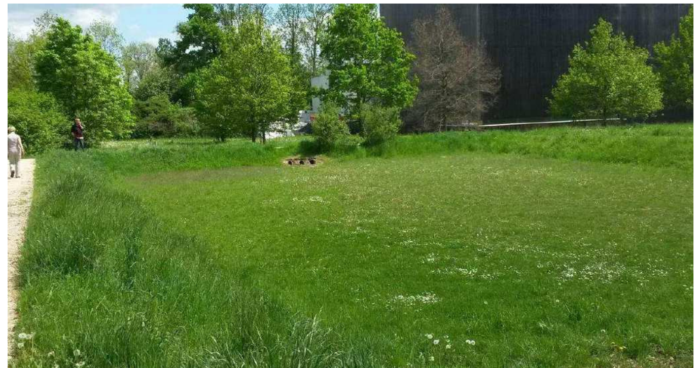
Obr.: Velký vsakovací průleh (zdroj: publikace „Vsakování srážkových vod“, Metodická pomůcka ministerstva pro místní rozvoj)
