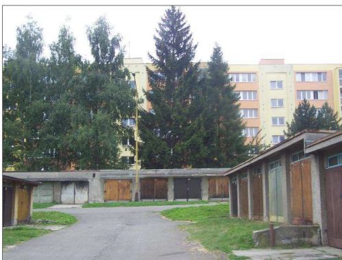
11. Areál hromadných boxových garáží, v pozadí panelové domy ulice Polní.
